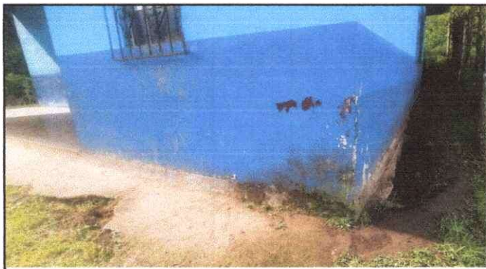
Foto 3: PINTURA EN MURO EXTERIOR E INTERIOR
