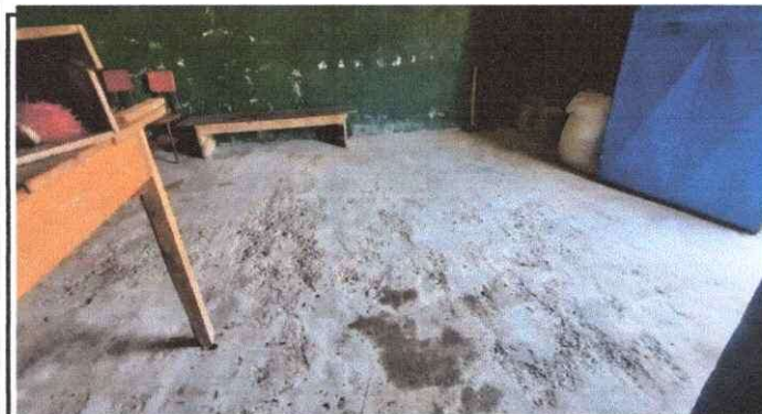
Foto 5: SUSTITUCION DE PISO DE CONCRETO DETERIORADO POR PISO CERAMICO EN COCINA
