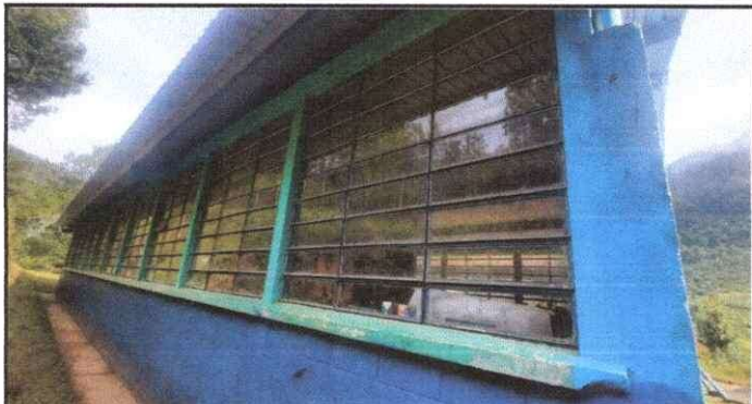
Foto1: PINTURA EN MURO EXTERIOR E INTERIOR
