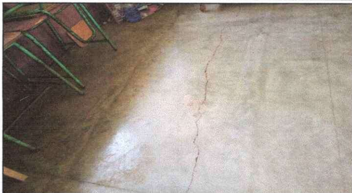
Foto 2: SUSTITUCION DE PISO DE CONCRETO DETERIORADO A PISO CERAMICO.
