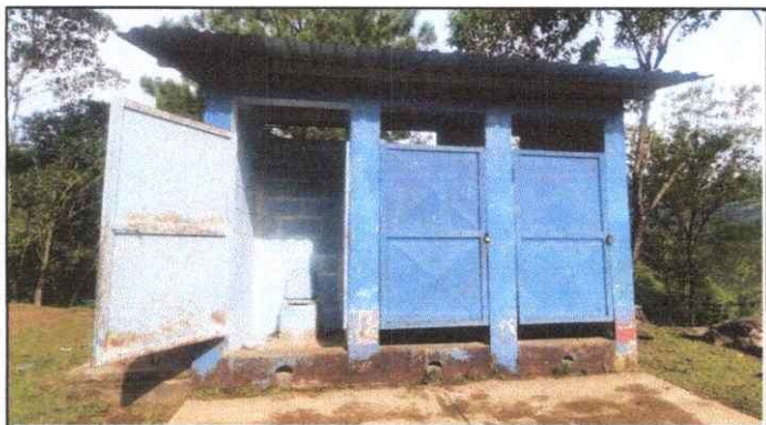
Foto 4: PINTURA EN MURO EXTERIOR E INTERIOR (BAÑOS)
