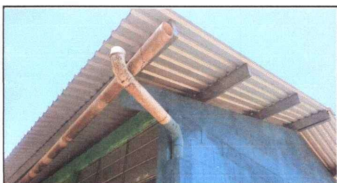
Foto 6: SUSTITUCION DE CANAL DE TUBO DETERIORADO POR CANAL DE LAMINA
